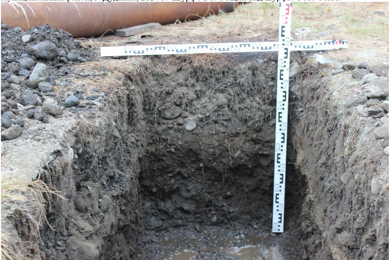
Рис. 24. «Строительство газопровода от котельной № 7 до котельной «Дукла» и газопоршневой электростанции мощностью 3МВт», Красноярский край, Таймырский Долгано-Ненецкий муниципальный район, г. Дудинка, 2024 г. Шурф № 1. Северная стенка шурфа. Фото с юга.
