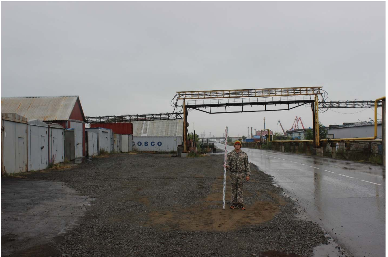
Рис. 19. «Строительство газопровода от котельной № 7 до котельной «Дукла» и газопоршневой электростанции мощностью 3МВт», Красноярский край, Таймырский Долгано-Ненецкий муниципальный район, г. Дудинка, 2024 г. Общий вид. Фото с северо-запада. Точка съемки № 9.
