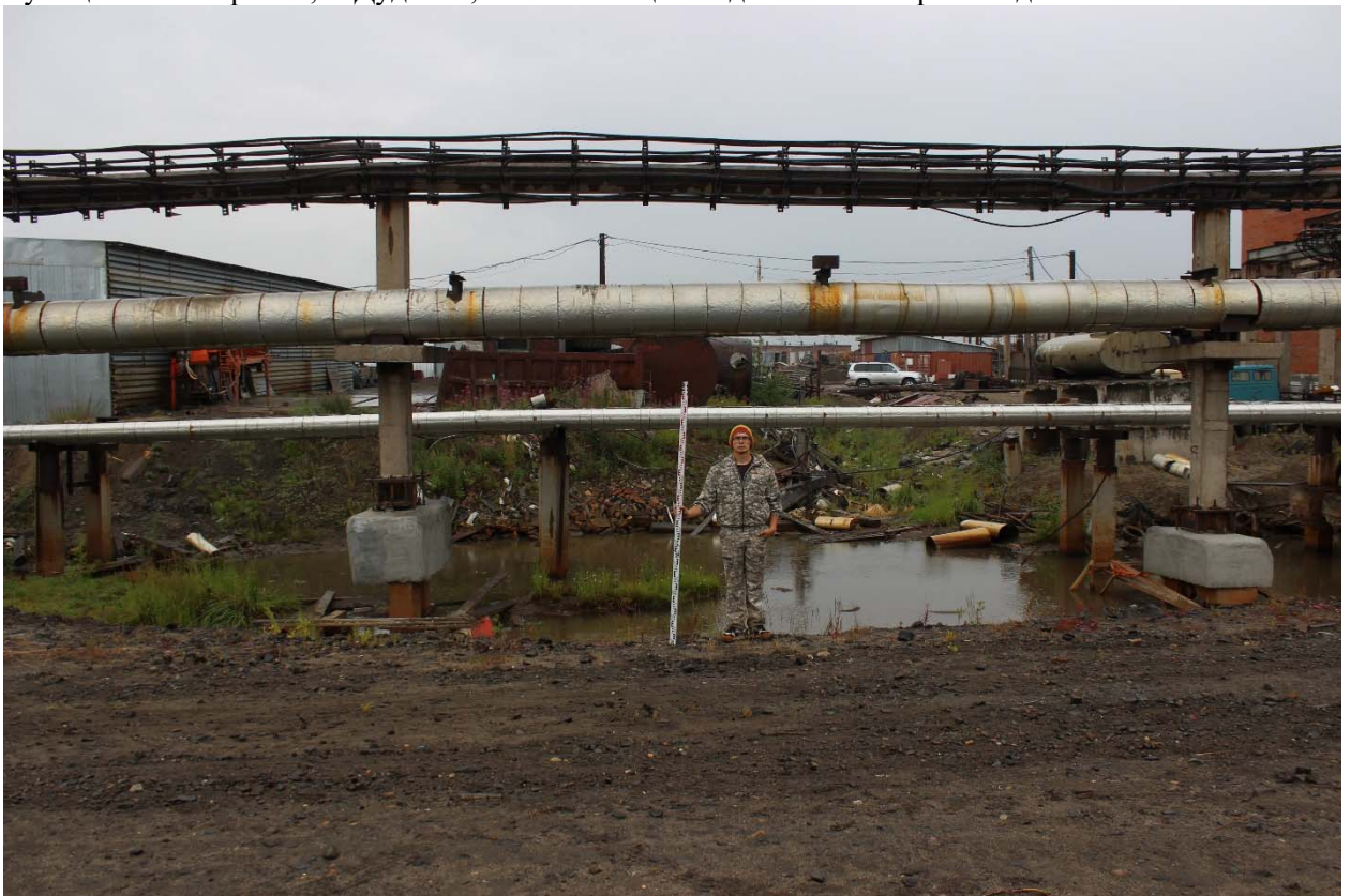
Рис. 12. «Строительство газопровода от котельной № 7 до котельной «Дукла» и газопоршневой электростанции мощностью 3МВт», Красноярский край, Таймырский Долгано-Ненецкий муниципальный район, г. Дудинка, 2024 г. Общий вид. Фото с юго-запада. Точка съемки № 2.
