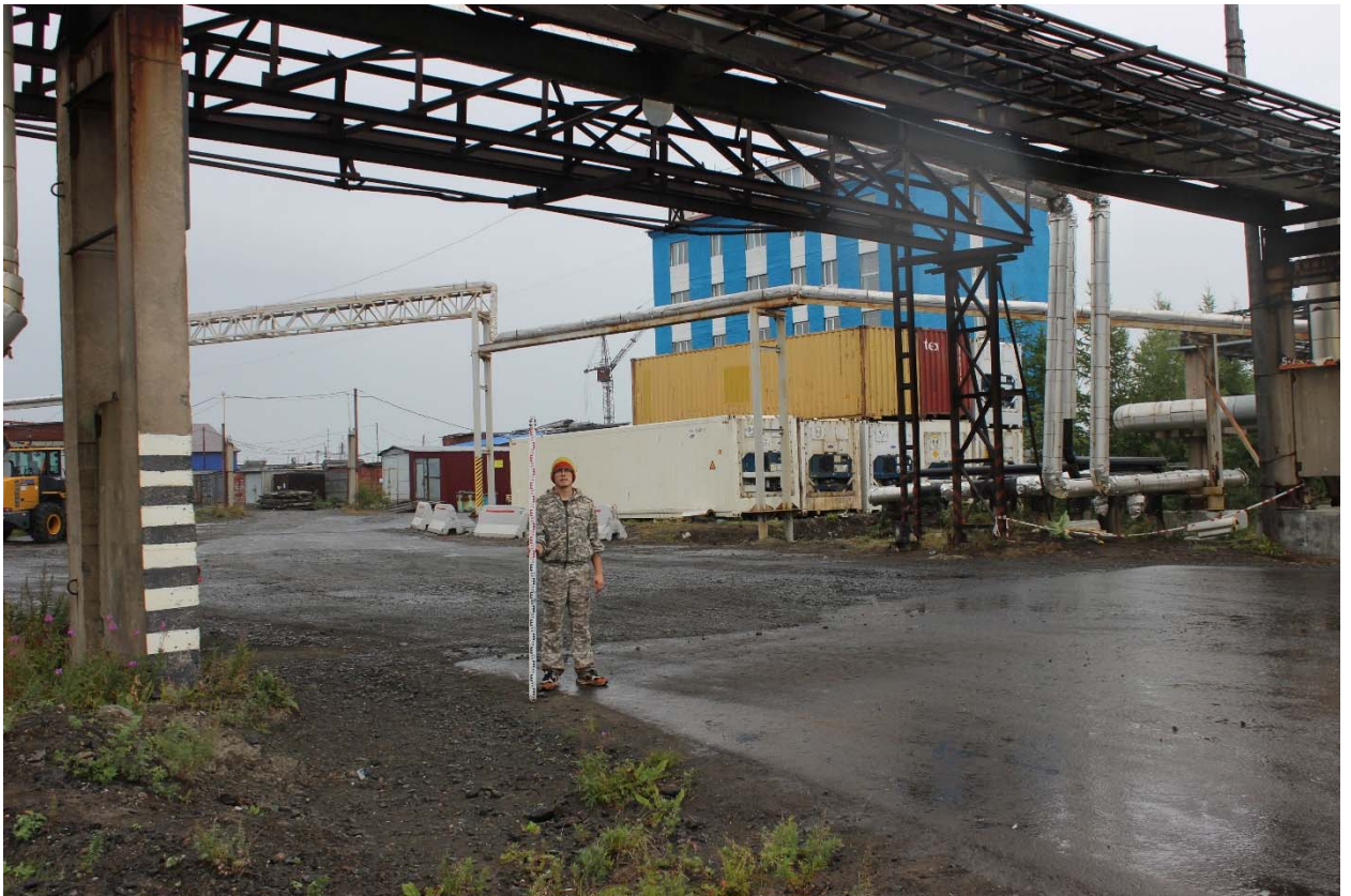
Рис. 17. «Строительство газопровода от котельной № 7 до котельной «Дукла» и газопоршневой электростанции мощностью 3МВт», Красноярский край, Таймырский Долгано-Ненецкий муниципальный район, г. Дудинка, 2024 г. Общий вид. Фото с юго-запада. Точка съемки № 7.
