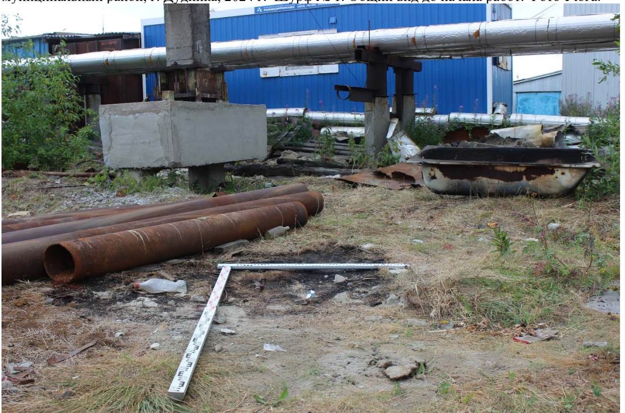
Рис. 22. «Строительство газопровода от котельной № 7 до котельной «Дукла» и газопоршневой электростанции мощностью 3МВт», Красноярский край, Таймырский Долгано-Ненецкий муниципальный район, г. Дудинка, 2024 г. Шурф № 1. Разметка шурфа. Фото с юга.
