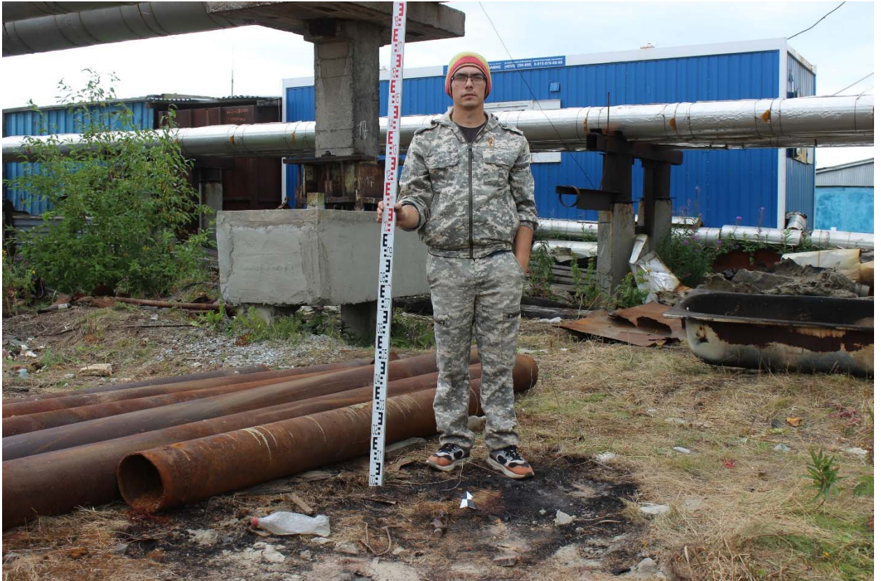
Рис. 21. «Строительство газопровода от котельной № 7 до котельной «Дукла» и газопоршневой электростанции мощностью 3МВт», Красноярский край, Таймырский Долгано-Ненецкий муниципальный район, г. Дудинка, 2024 г. Шурф № 1. Общий вид до начала работ. Фото с юга.
