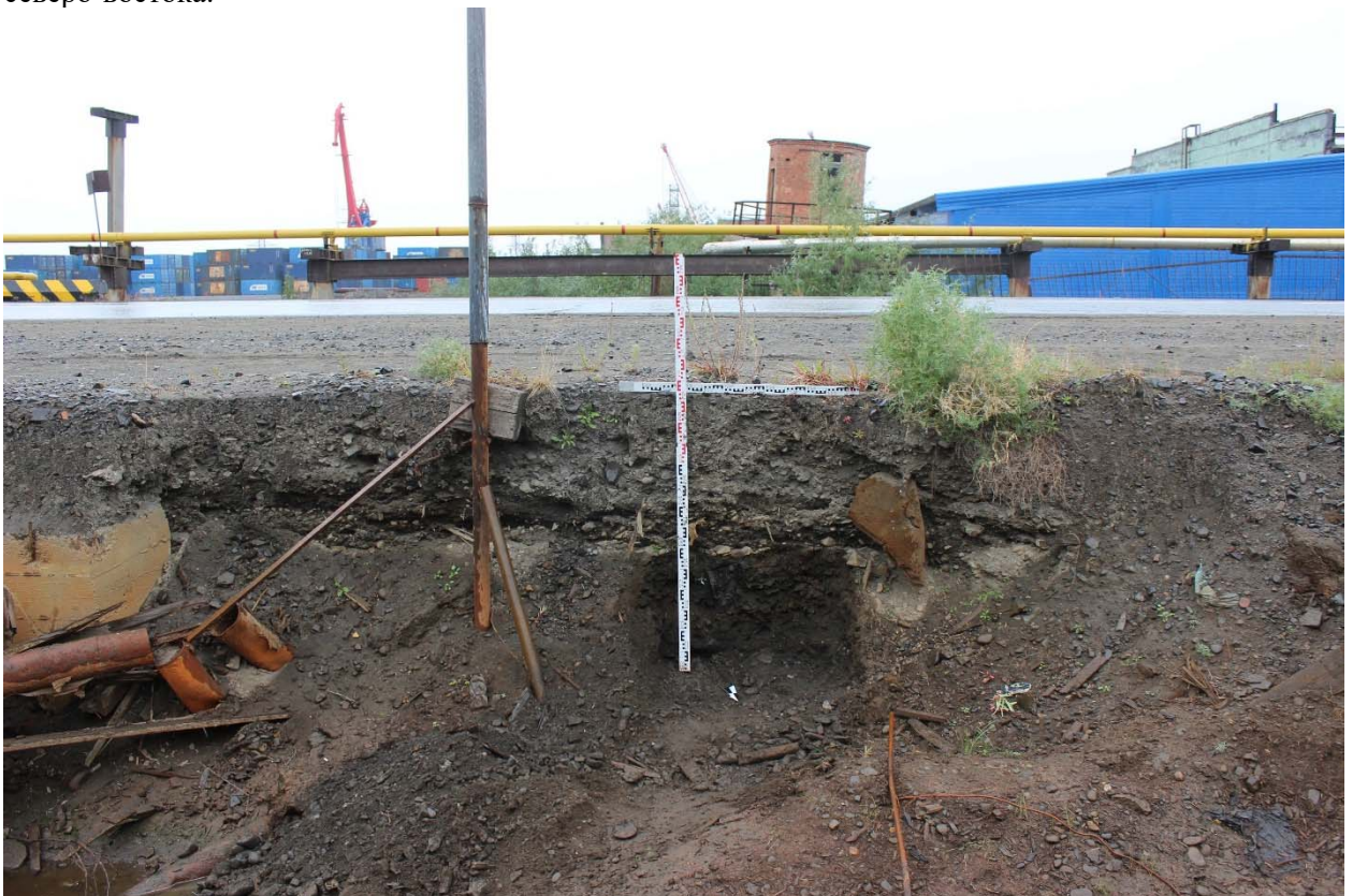
Рис. 28. «Строительство газопровода от котельной № 7 до котельной «Дукла» и газопоршневой электростанции мощностью 3МВт», Красноярский край, Таймырский Долгано-Ненецкий муниципальный район, г. Дудинка, 2024 г. Зачистка № 1. Общий вид зачистки. Фото с северо-востока.
