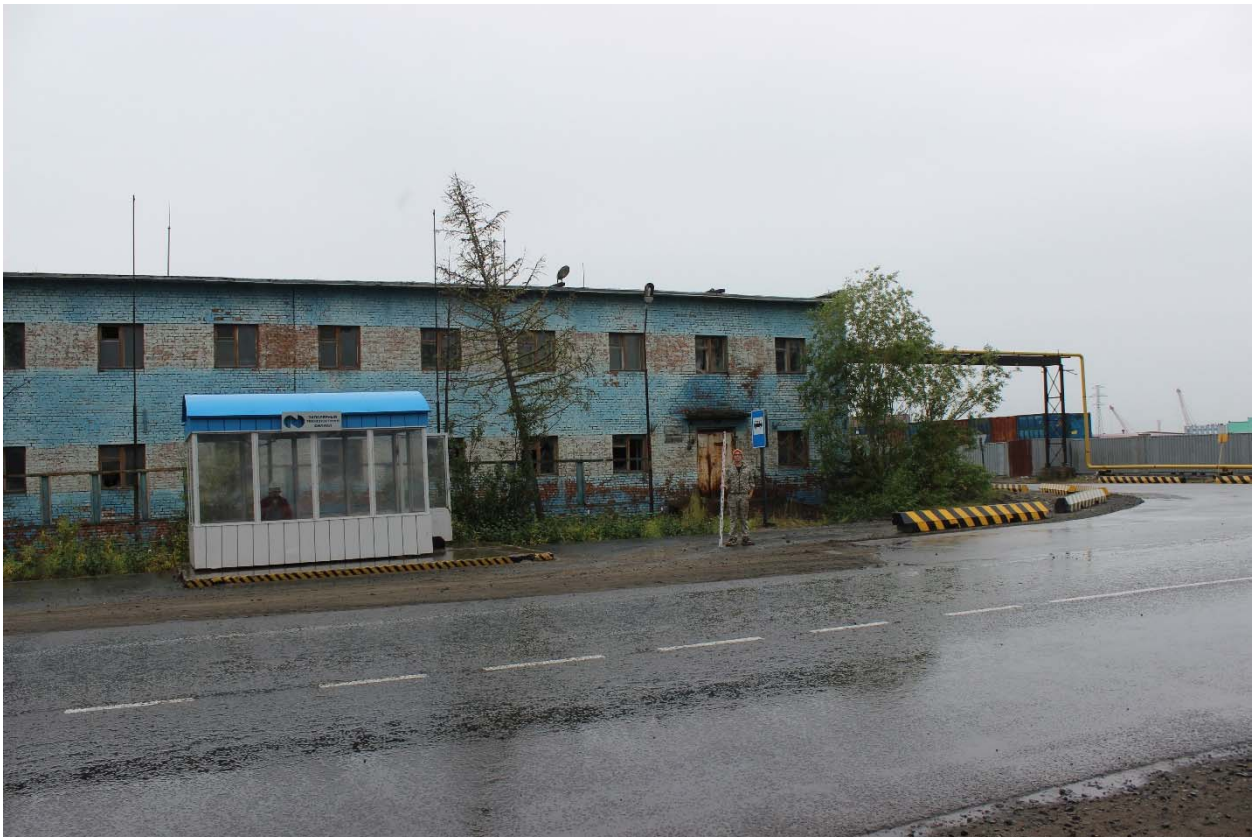
Рис. 13. «Строительство газопровода от котельной № 7 до котельной «Дукла» и газопоршневой электростанции мощностью 3МВт», Красноярский край, Таймырский Долгано-Ненецкий муниципальный район, г. Дудинка, 2024 г. Общий вид. Фото с востока. Точка съемки № 3.
