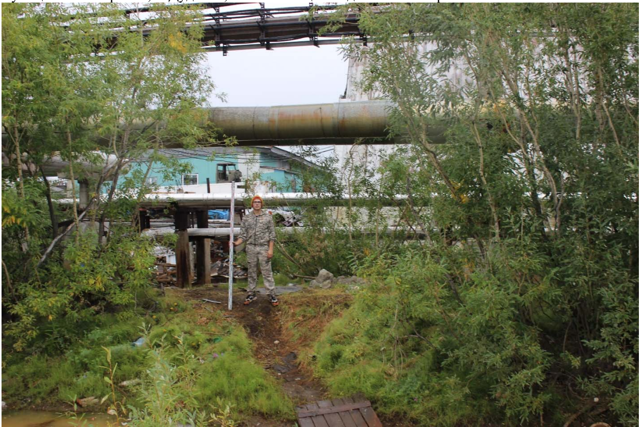
Рис. 16. «Строительство газопровода от котельной № 7 до котельной «Дукла» и газопоршневой электростанции мощностью 3МВт», Красноярский край, Таймырский Долгано-Ненецкий муниципальный район, г. Дудинка, 2024 г. Общий вид. Фото с юго-запада. Точка съемки № 6.
