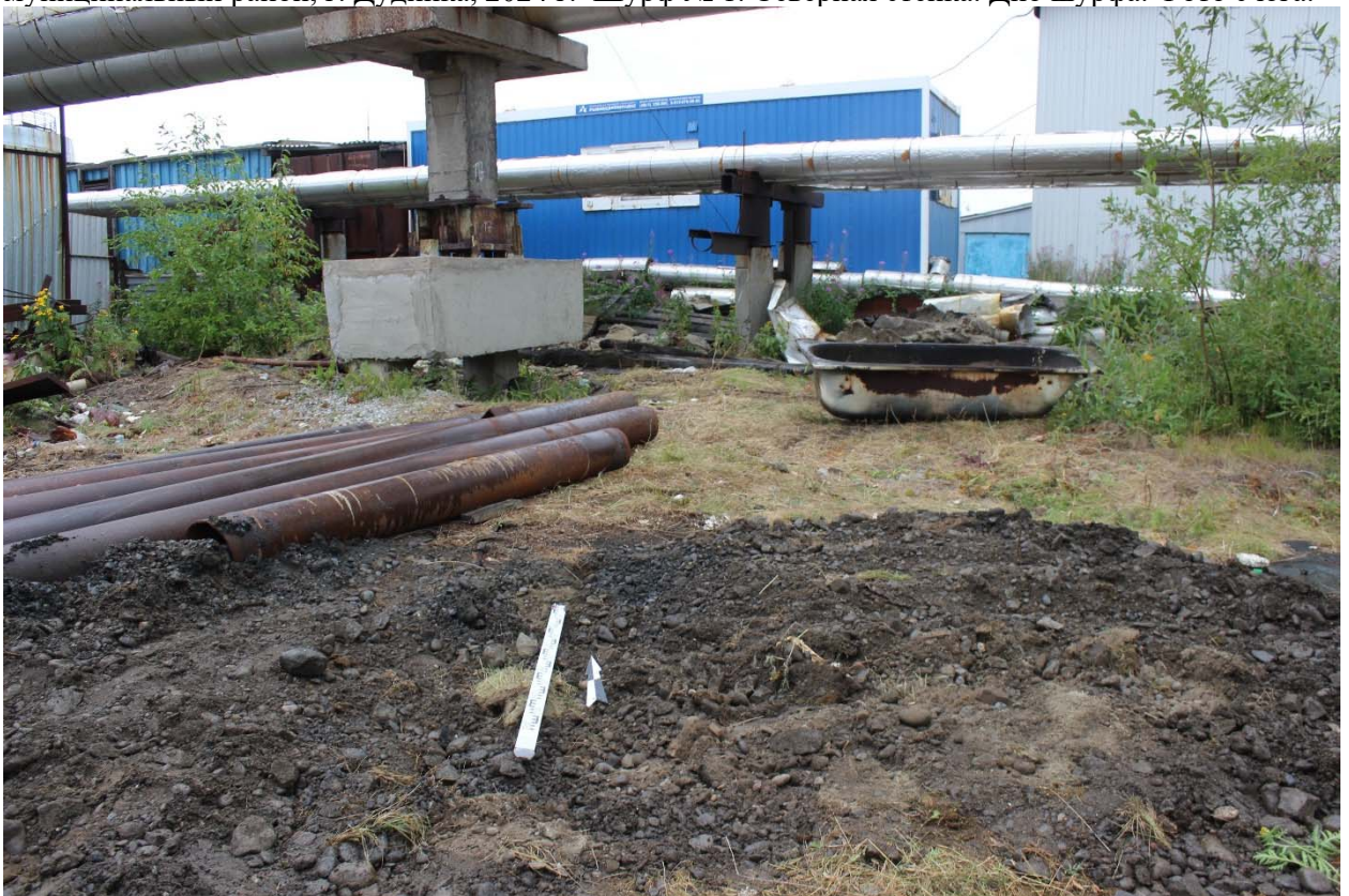
Рис. 26. «Строительство газопровода от котельной № 7 до котельной «Дукла» и газопоршневой электростанции мощностью 3МВт», Красноярский край, Таймырский Долгано-Ненецкий муниципальный район, г. Дудинка, 2024 г. Шурф № 1. Рекультивация шурфа. Фото с юга.
